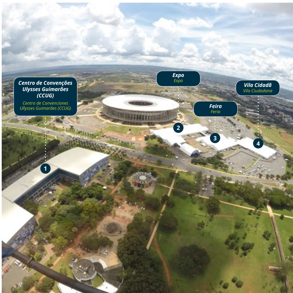
Figura 3: Instalações do Evento.
